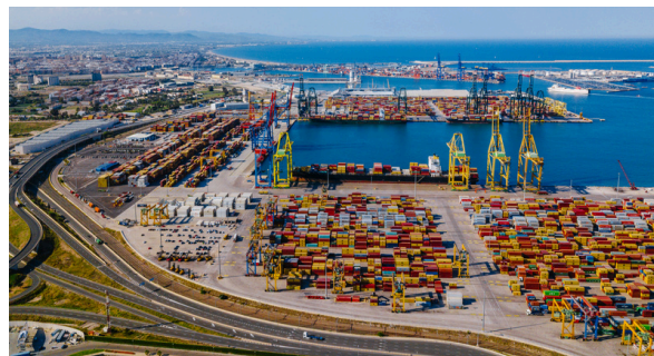
Vista aérea del Puerto de Valencia. ©AdobeStock.
