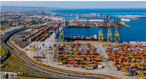
Vista aérea del Puerto de Valencia. ©AdobeStock.
