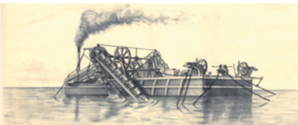
Vista de una de las dragas destinadas a la limpia del Puerto del Grao de Valencia en Revista de Obras Públicas , 1854. Xilografía a la contrafibra. ©Autoridad Portuaria de València.
