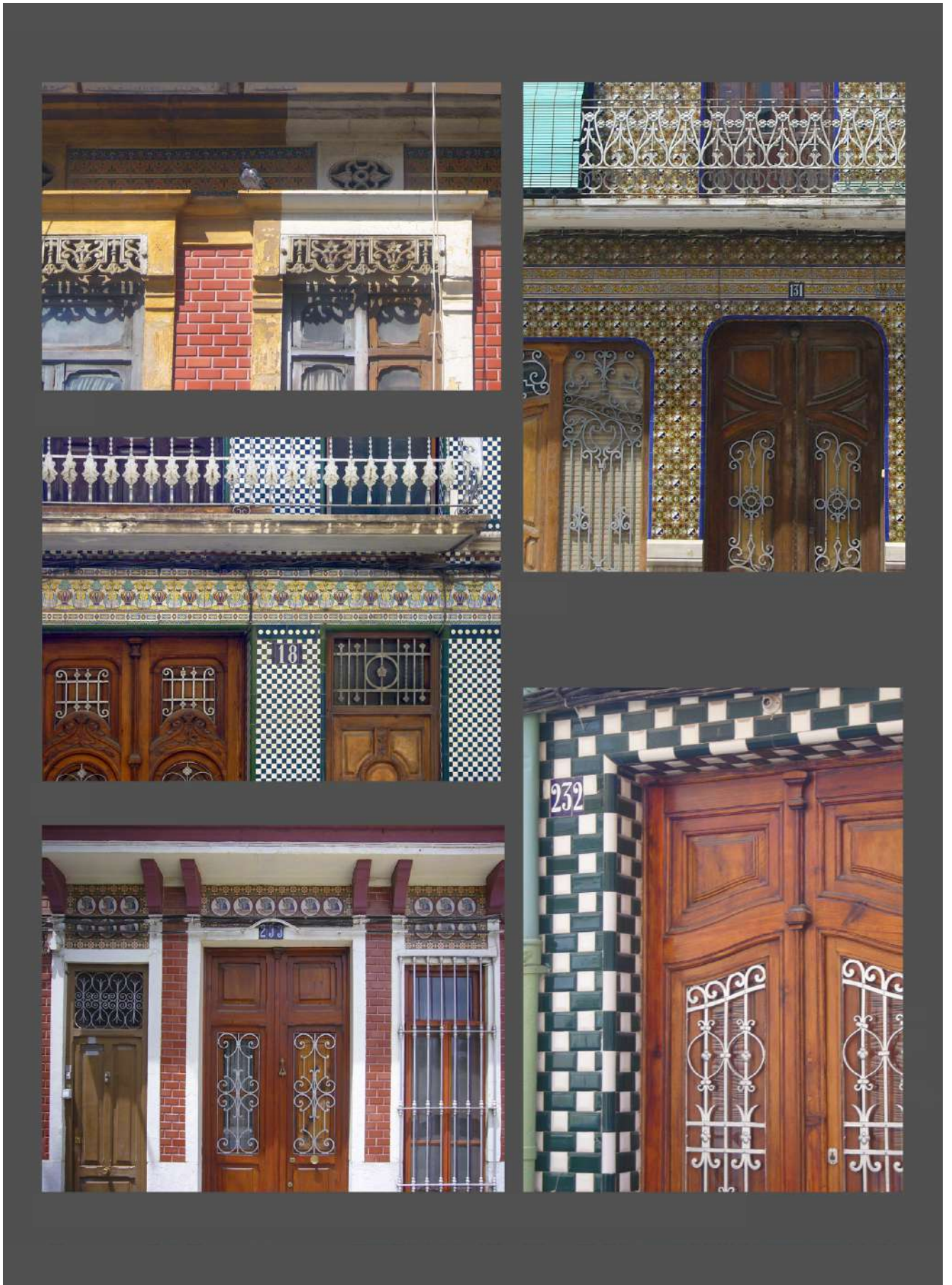
Figura 32. Detalles de materiales de las fachadas de las casas del Cabanyal. ©Los autores.
